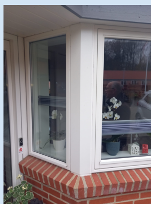
Vinduer med aluminiumsinddækning med lav vedligeholdelsesgrad
