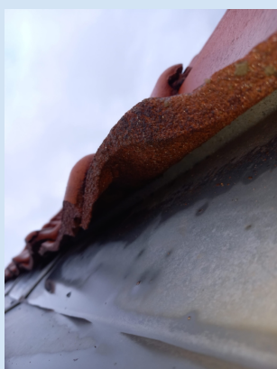
Betontag - Skotrende, skotrendezink med opbuk
