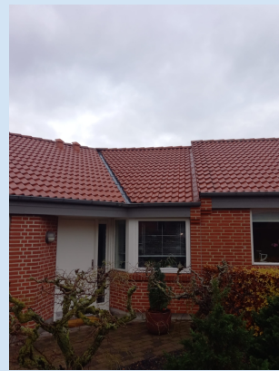
Betontag - Skotrende og forskydning i tagflade
