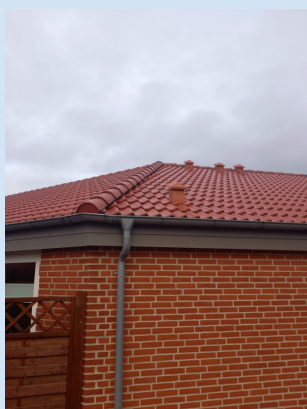
Betontag - Grat med ryggningssten
