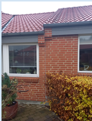
Betontag - Skotrende og forskydning i tagflade
