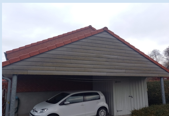
Carport med gavlbeklædning i fibercement
