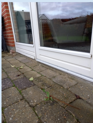
Terrassedør med sideparti, sideparti med drypnæse i træ
