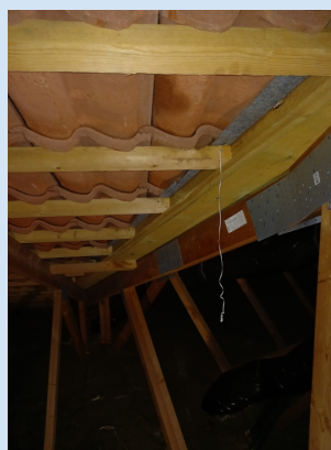
Tagkonstruktion ved plankekelen
