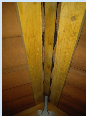
Rygning udført med ventileret rygningbånd for udluftning af tagkonstruktion
