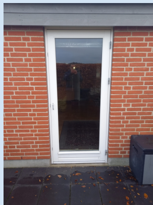
Terrassedør med begrænset udhæng og tæt på terrænet med mulighed for opsprøjt
