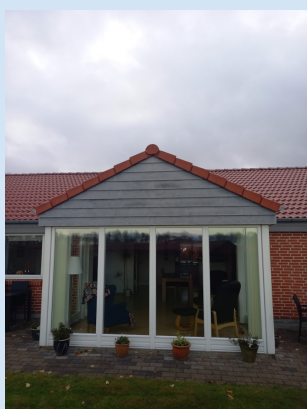
Udestue med gavlbeklædning i fibercement
